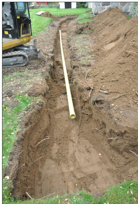
Kirkon eteläpuolen itä–länsi-suuntainen viemäriöja suurimmassa syvyydessään. Idästä.
