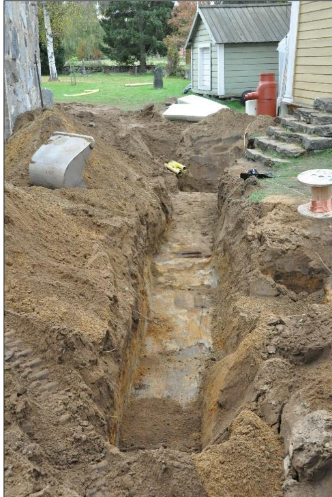
Kirkon länsipuolen pohjoinen–etelä-suuntainen viemärioja lopullisessa syvyydessään. Pohjoisesta.
