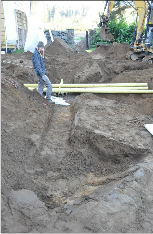
Tapulin pohjoispuolella olevan kirkkoaidan portin suunnasta kohti kirkon luoteisnurkkaa kaivettu sähkökaapelioja
