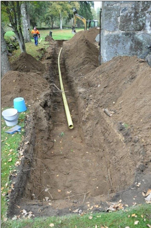
Kirkon itäpuolen pohjoinen–etelä-suuntainen viemärioja suurimpaan syvyyteensä kaivettuna. Pohjoisesta.
