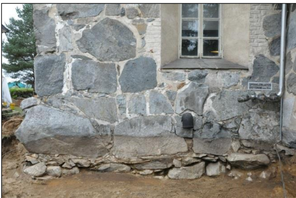
Yleiskuva kirkon eteläseinän alaosasta asehuoneen länsipuolelta puhdistamisen jälkeen. Eteläkaakosta.
