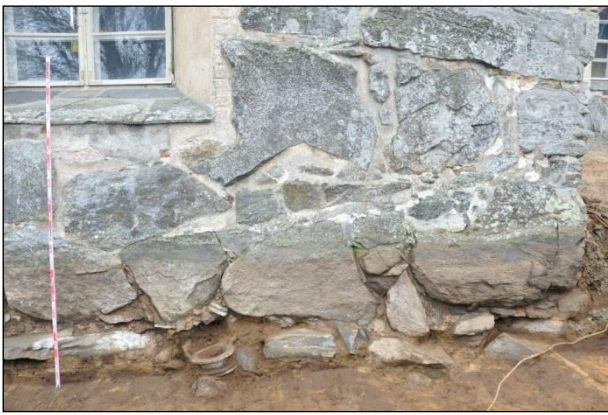
Sakastin pohjoisseinä alaosa esille puhdistettuna – länsipuolisko. Pohjoisluoteesta.
