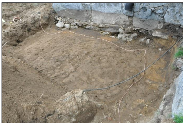
Asehuoneen länsipuolen bentoniittimattoalue lopulliseen syvyyteensä kaivettuna. Itäkaakosta.
