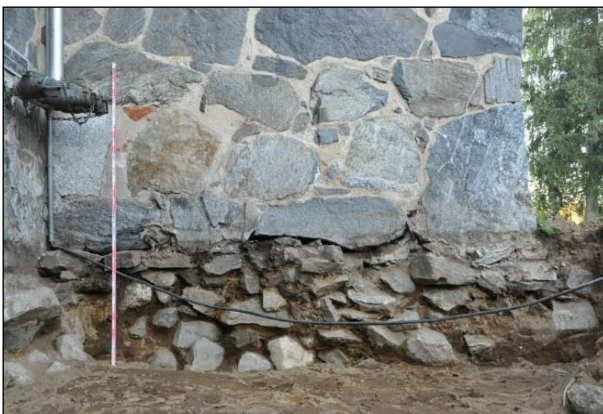
Asehuoneen länsiseinän alaosa esille puhdistettuna. Länsilounaasta.
