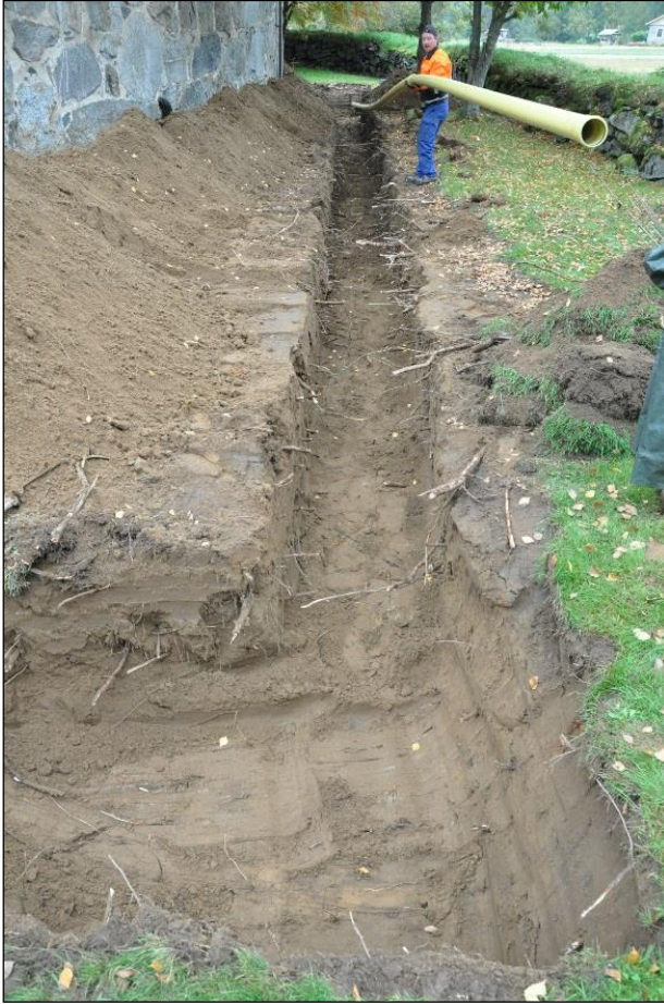
Kirkon itäpuolen pohjoinen–etelä-suuntainen viemärioja suurimpaan syvyyteensä kaivettuna. Etelästä.
