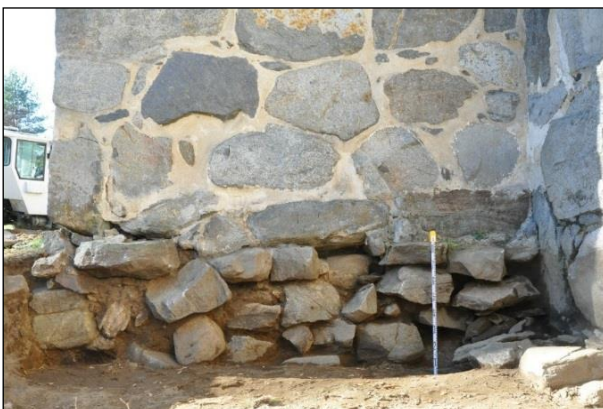
Asehuoneen itäseinän alaosa esille puhdistettuna. Itäkoillisesta.
