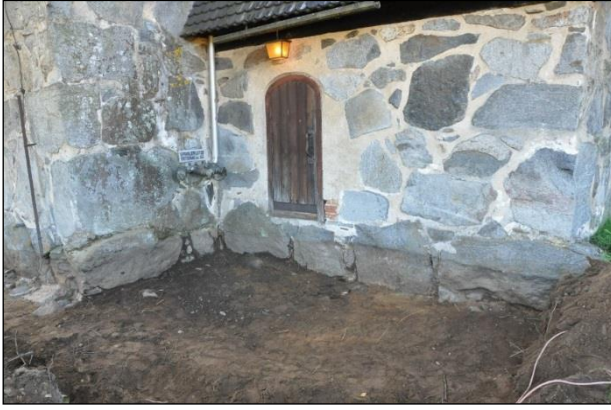
Sakastin itäseinän ja runkokuoneen pohjoisseinän alaosa esille puhdistettuina. Pohjoiskoillisesta.
