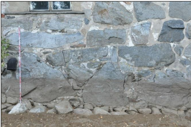
Runkohuoneen eteläseinän alaosa asehuoneen itäpuolella esille puhdistettuna – keskimäinen kolmannes. Eteläkaa-
