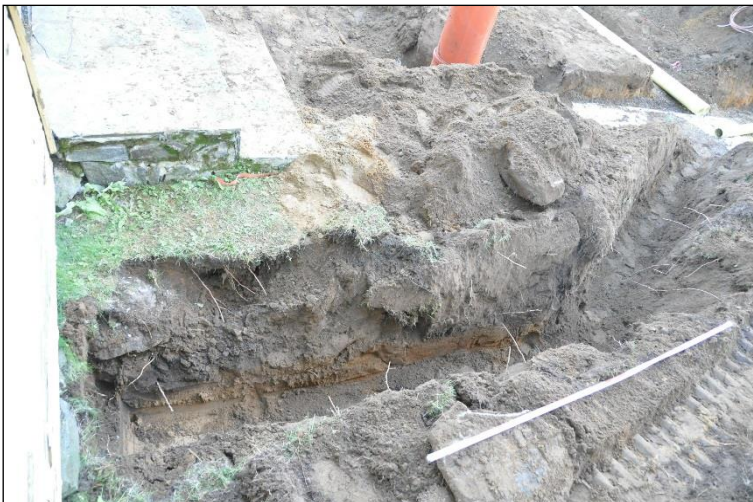
Haudan 13 luota kohti läpikäytävää kaivettu sähkökaapelioja suurimmassa syvyydessään. Luoteesta.
