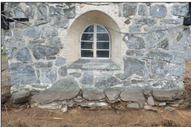
Sakastin pohjoisseinä alaosa esille puhdistettuna. Pohjoisluoteesta.
