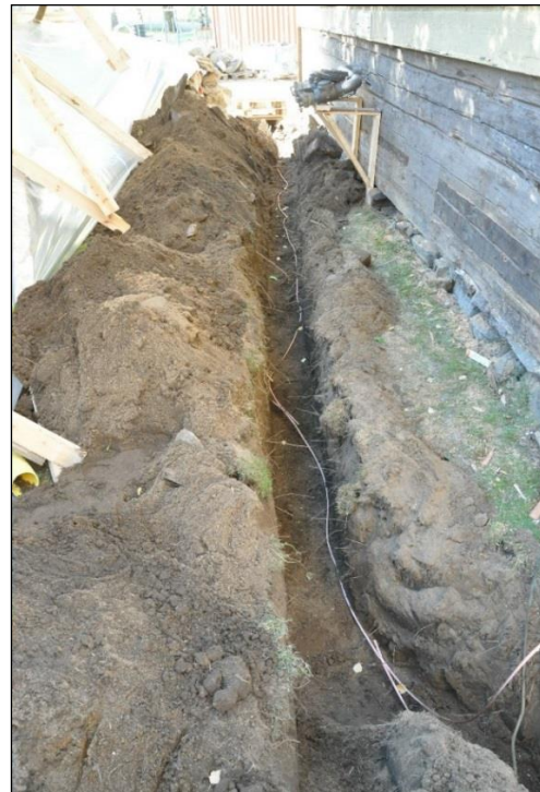
Tapulin kaakkoispuolen sähkökaapelioja suurimmassa syvyydessään – koillisosa. Etelästä.
