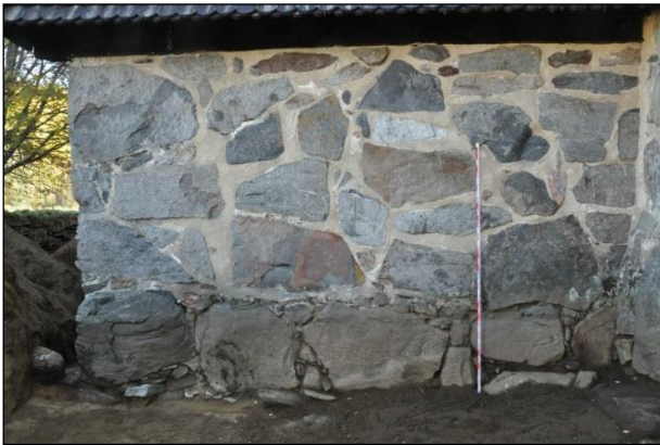
Sakastin länsiseinä alaosa esille puhdistettuna. Länsilounaasta.
