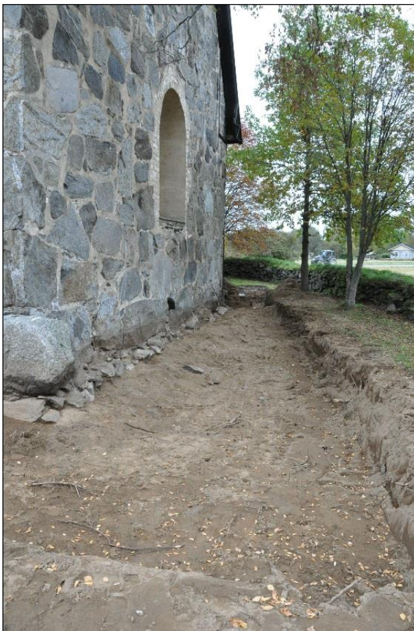
Kirkon itäpäädyn bentoniittimattoalue lopulliseen syvyyteensä kaivettuna. Kaakosta.
